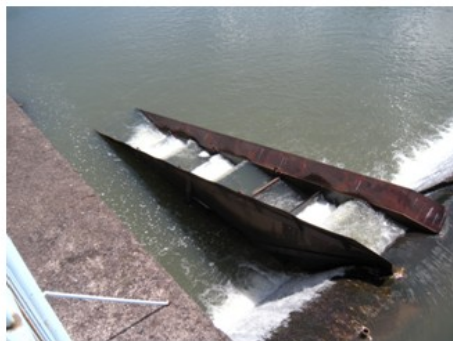
Captação - Escada de acesso de peixes
